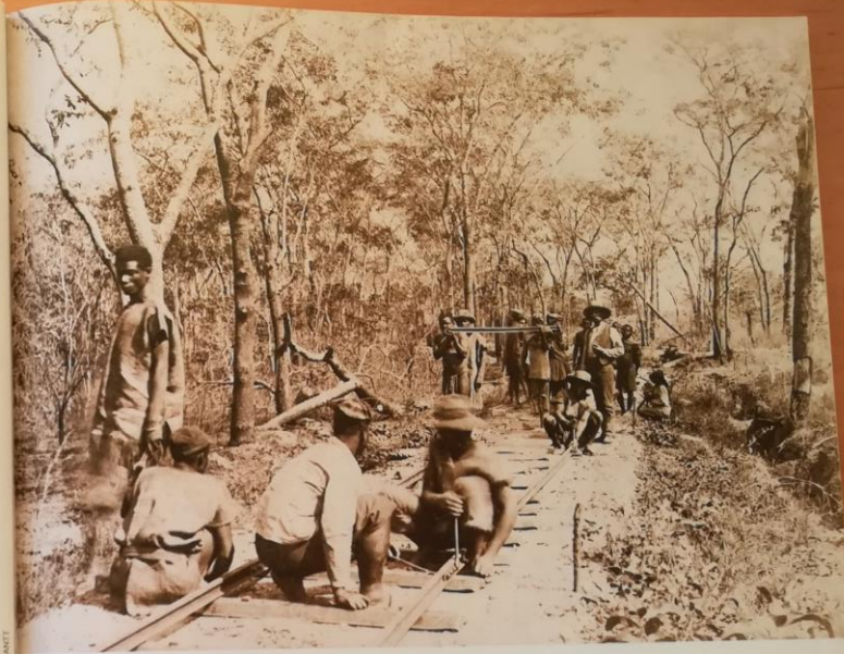
1892 Construção da linha de caminho-de-ferro Beira-Rodésia
